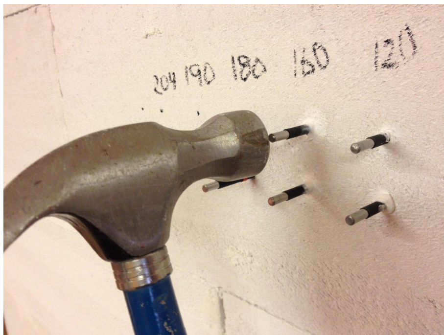
Foto 12. Inslagning av elektroder.
