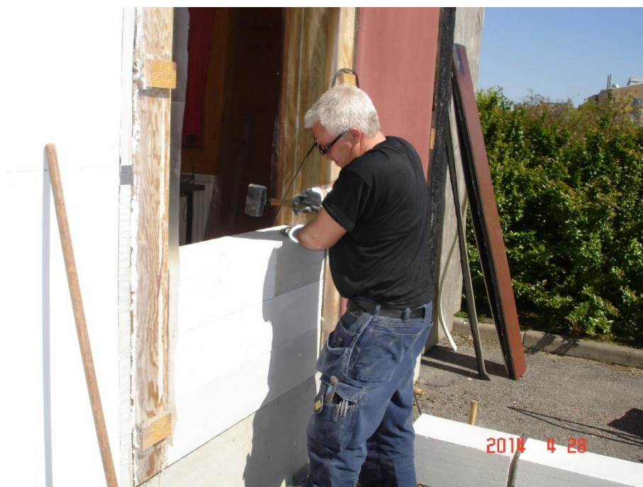
Foto 9. Uppmurning av provväggar.
